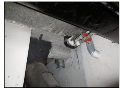
Photo N° 940 AMIANTE CIMENT -- LOCAL VO -1 Plafonds Coude de ventilation haute (Fibres-ciment)
