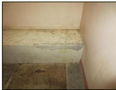
Photo N° 936 AMIANTE CIMENT -- ESCALIER RDC à -1 Gainses & coffres verticaux Ventilation basse (Fibres-ciment)
